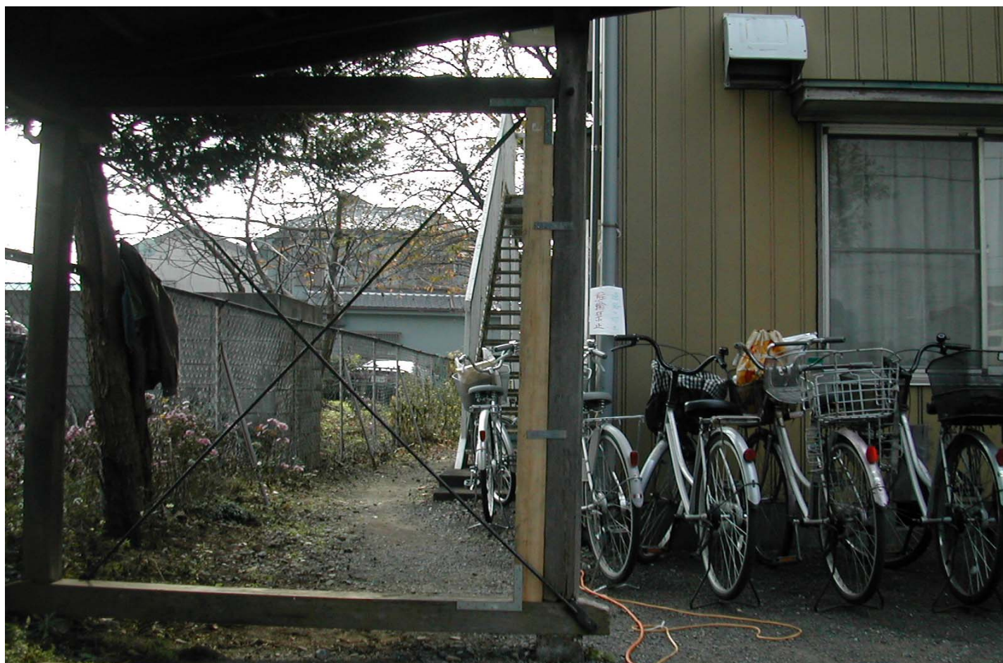
柱の補強、完成です！
